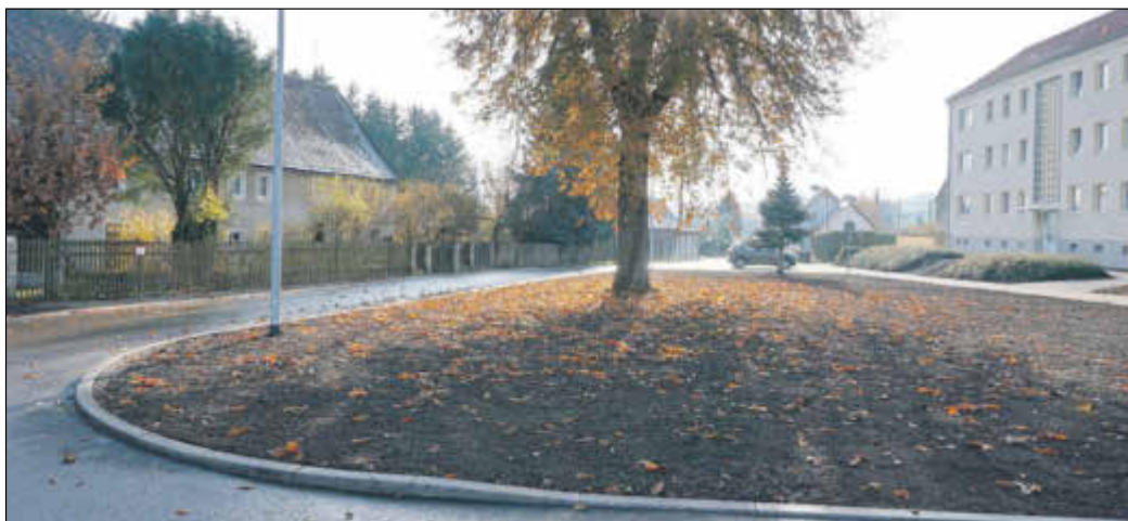
Straßenbau Am Steigerturm OT Halsbrücke
