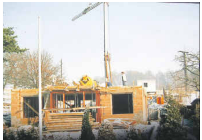
Das Erdgeschoss ist fertig
