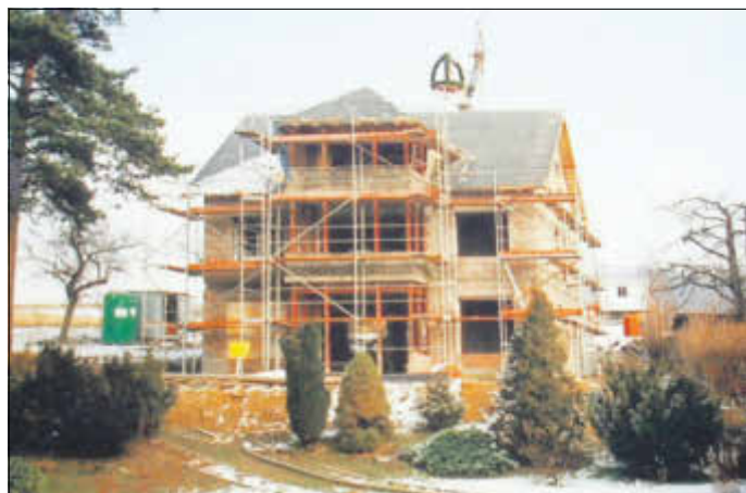
Den Bau ziert die Richtkrone
