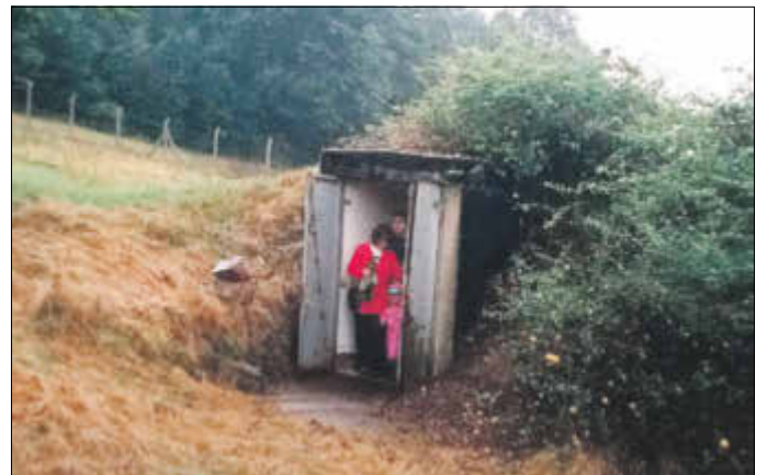
Bunkereingang 1999, jetzt völlig mit Sträuchern zugewachsen
