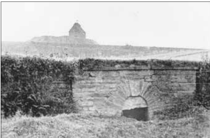
Der Hoffnungsschacht mit dem Mundloch der Aufschlagrösche
