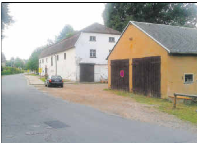
Gebäude vor Sanierung
