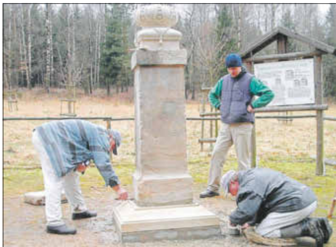
Mitarbeiter der Firma Hain bei letzten Arbeiten (Zimmermann)
