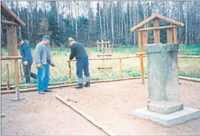
Vorbereitungsarbeiten durch den Heimatverein Hetzdorf im Dezember 1996
